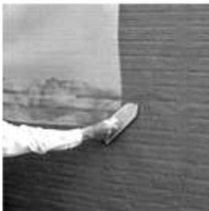
図 22 モルタル施工時のネット伏せ込み
